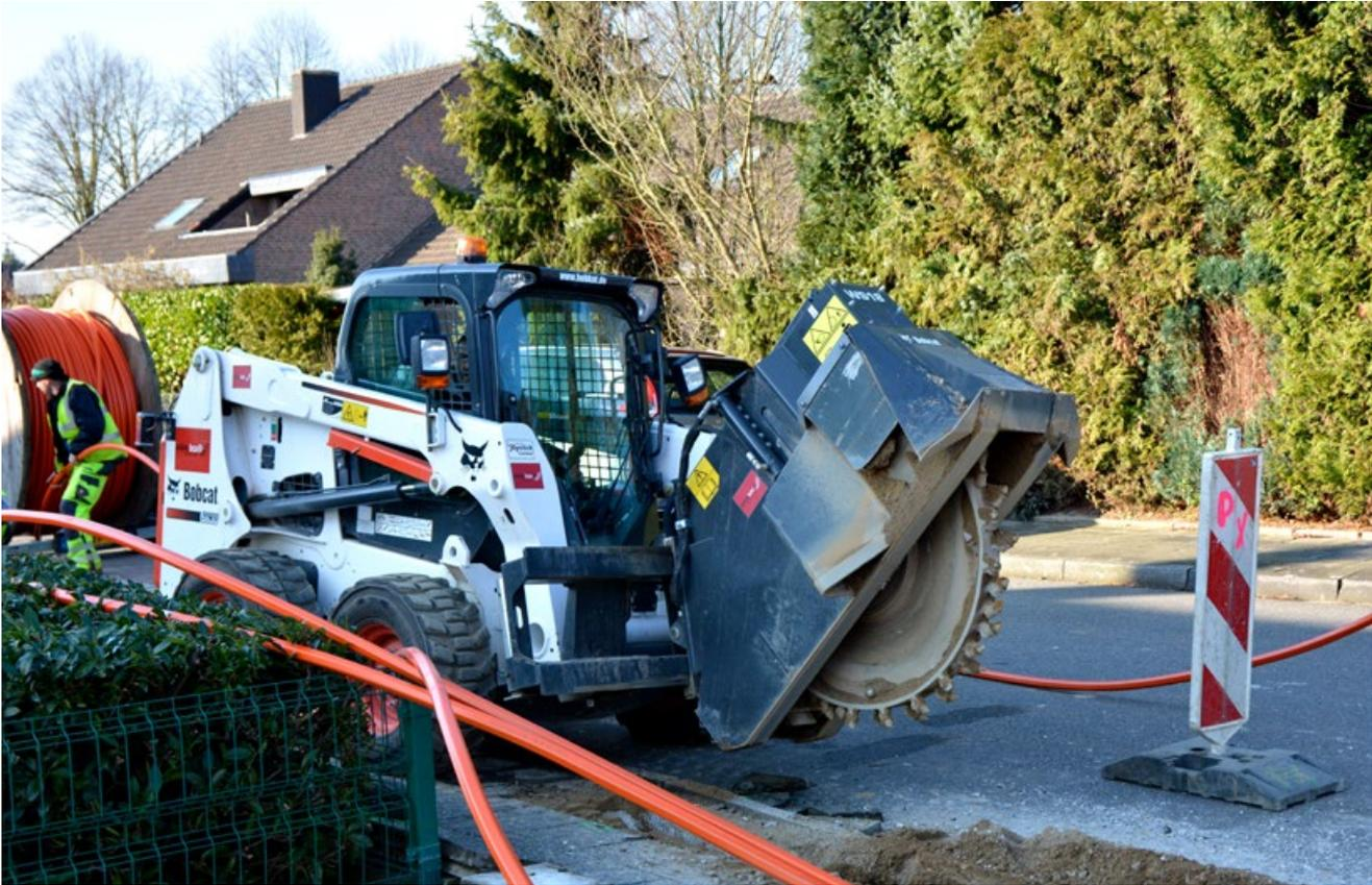
Die Bauarbeiten starten, um 1.500 km Glasfaserkabel zu verlegen.
